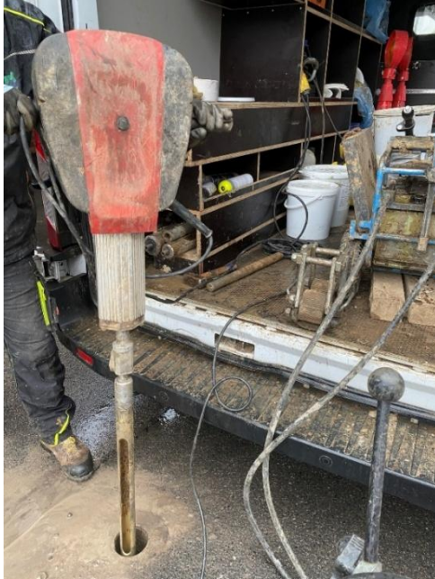
Bohrung in den Boden 2 Meter tief
